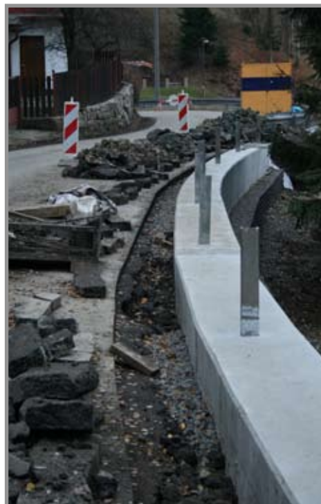
Janov – oprava komunikací
